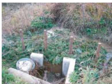
ソダ柵による濁水流入防止
