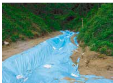
シートによる濁水発生防止
