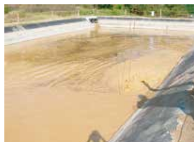
凝集剤による濁水処理
