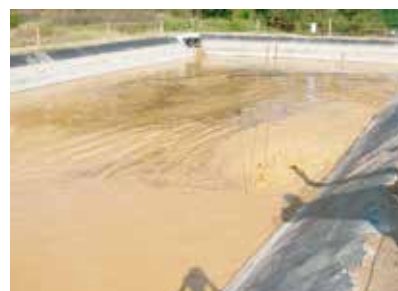
凝集剤による濁水処理
