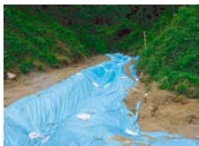
シートによる濁水発生防止
