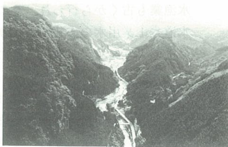
筑後川上流玖珠川の猪牟田ダム
