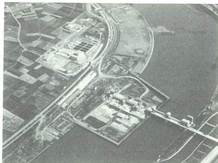
筑後川下流筑後大堰建設現場
