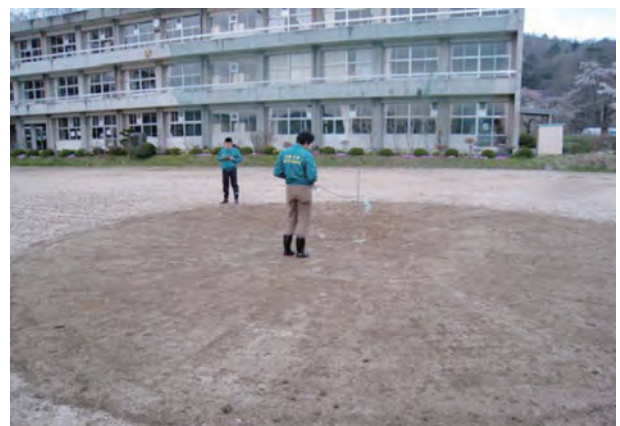
図8 山木屋中学校における表土除去の様子
