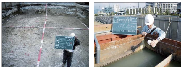
掘削除去後の出来型管理
