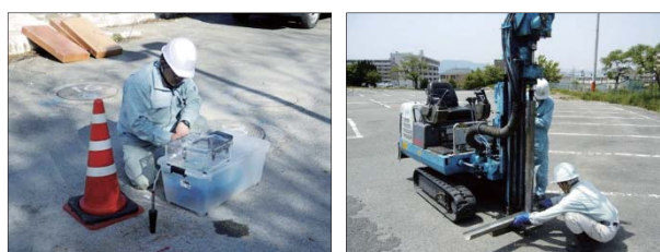
図 2 土壌ガスの採取(左)とボーリングマシン(右)
