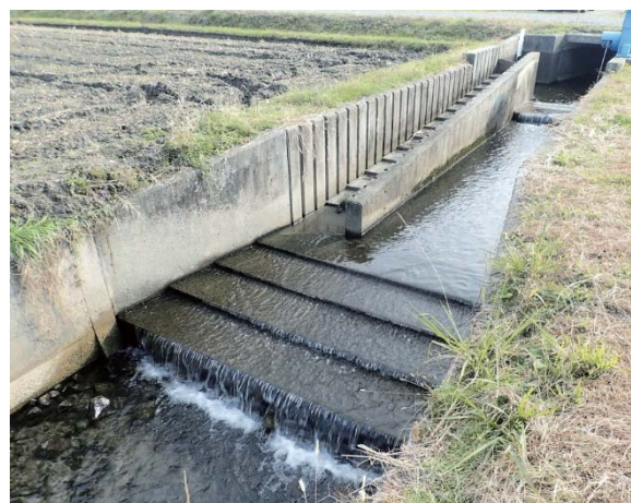
図7 非かんがい期の転倒ゲート部の落差 (平成28年12月8日)
