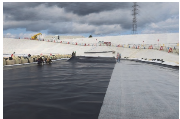
写真1 埋立地における遮水シートの敷設作業 (遮水シートは不織布の上面に敷設される)
