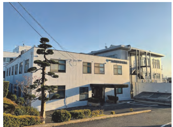
写真 12 正面より管理棟及び4号館を望む
