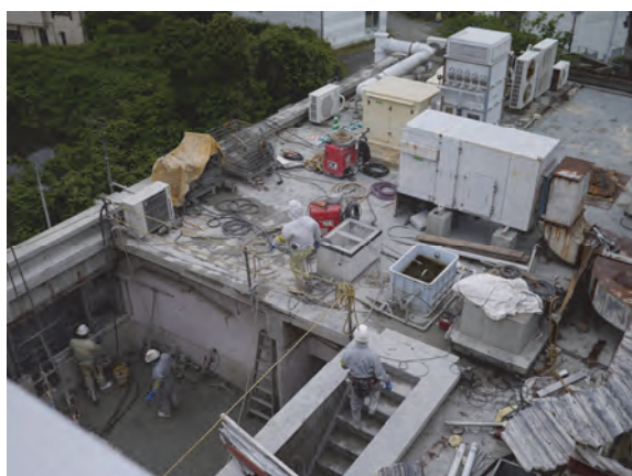
写真1 2号館の部分解体
