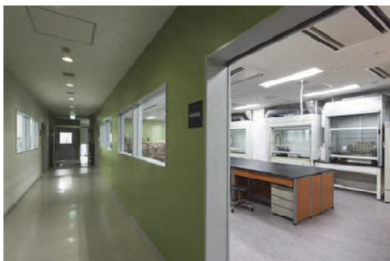
写真5 廊下側ガラス面の設置(有機前処理室)
