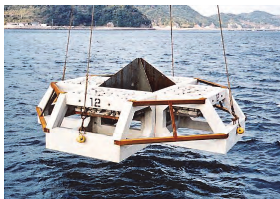
図 1 自然エネルギー（潮流）を制御する人工魚礁
